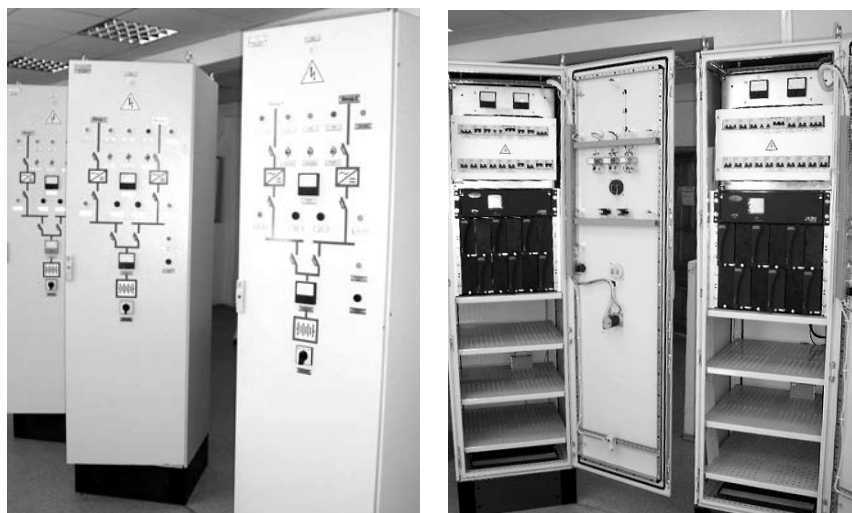
Рис.4. Внешний вид шкафа оперативного тока без установленных батарей
