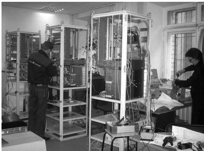
Рис. 3. Сборка шкафа оперативного тока
