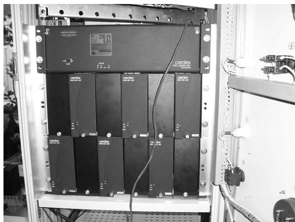
Рис. 5. Контроллер и преобразователь Cordex
